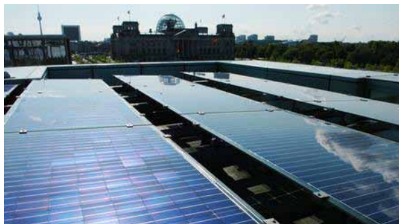
Solaranlage auf dem Dach des Bundeskanzleramtes (Quelle: Bundesbildstelle / Bienert)
